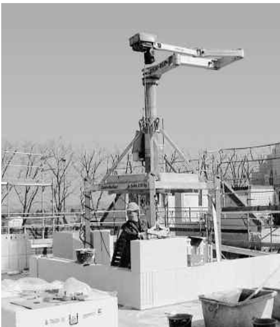
Wirtschaftlichkeit im Mauerwerksbau: Mit dem Steinversetzkran wird die körperliche Arbeit erleichtert und Baustellenabläufe beschleunigt. Foto: Layher Bautechnik
