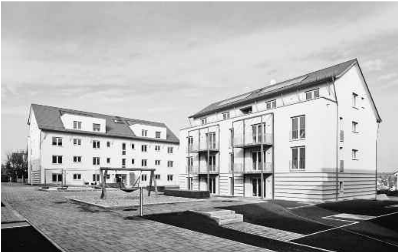
Frankfurt-Kalbach: Insgesamt 5 Geschossbauten wurden nach Passivhausstandard in massiver Ziegelbauweise errichtet. Zum Einsatz kam auch hier der zertifizierte Mauerziegel von Unipor. Foto: Unipor
