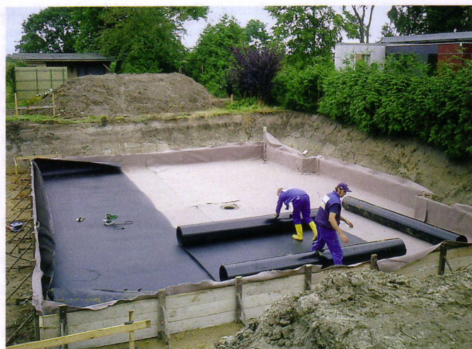
Die ABG®-Dichtungsbahn wird im Sohlen- und Schalungsbereich verlegt
