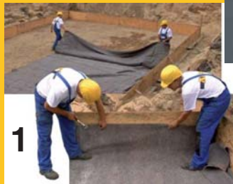
Заделка герметизирующего полотна (деталь)
