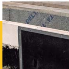
Заделка герметизирующего полотна (деталь)
