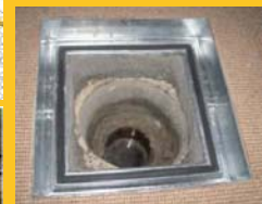
Смотровая шахта с насосом для откачивания воды:
