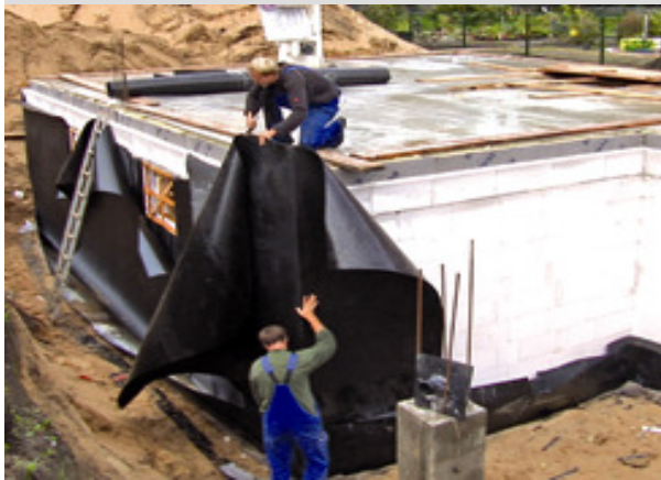
Das ABG®-Kellerdicht-System stellt mit seiner Kombination aus Dichtungsbahn und Atmungsfixbahn eine atmungsaktive Wannenzulassung dar, die Schutz gegen von außen drückendes Wasser bietet. Foto: pm
