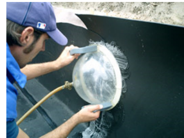
Bei der Dichtigkeitsprüfung
