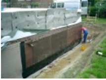
Abdichtung der Wände: zunächst wird die...
