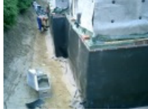
... anschließend wird die ABG-Dichtungsbahn...
