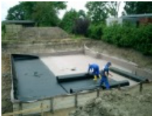
Die ABG-Dichtungsbahn wird auf einem Schutzvlies... Fotos: ABG
