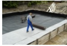
Nach erfolgreicher Prüfung der Schweißnähte folgt...
