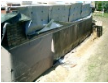
Zum Schluss wird das äußere ABG-Schutzvlies...
