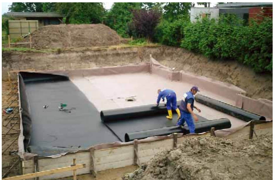
Darauf folgt die ABG-Dichtungsbahn.
