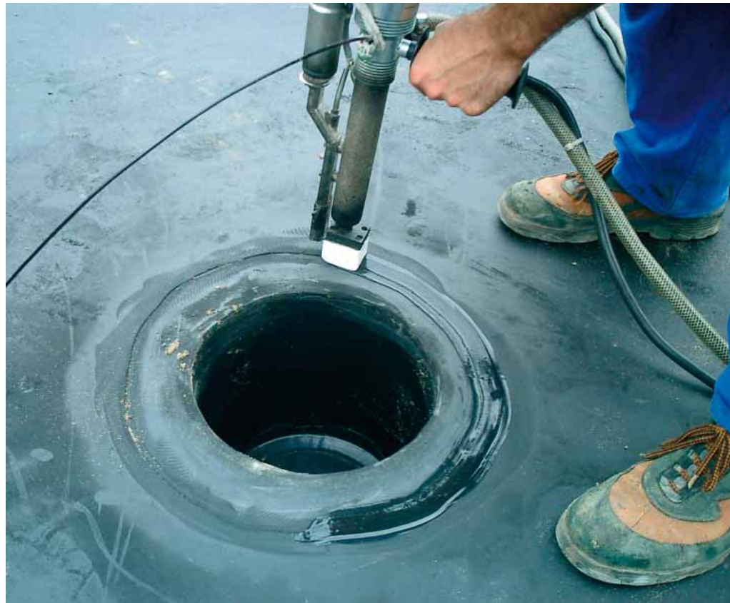
Die Baufeuchtigkeit aus Sohle, Wand und Decke wird u.a. über den Kontrollschacht abgeführt.
